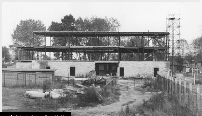
areál výstavba šatnového objektu
