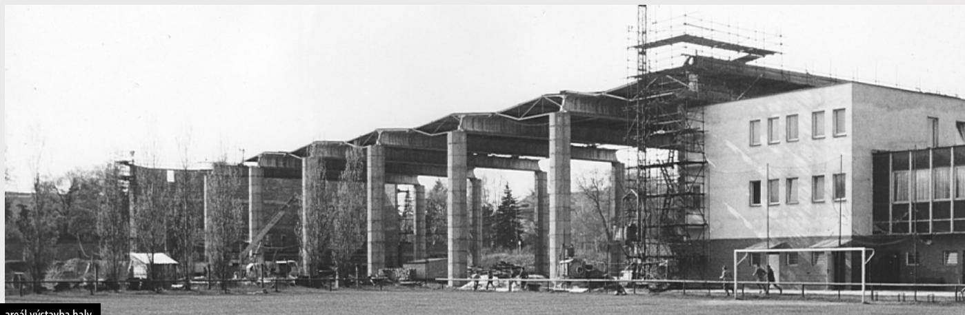
areál výstavba haly
